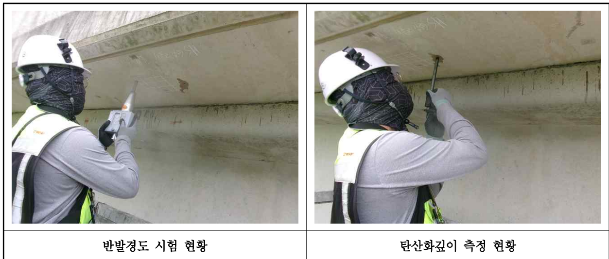
【사진 2.4.1】 콘크리트 내구성조사 현황
