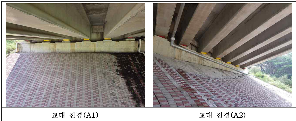
【사진 2.3.35】 교대 전경
