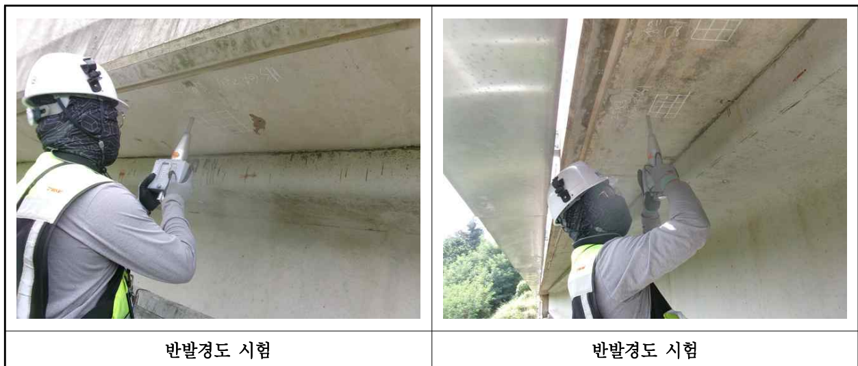
【사진 2.4.2】 반발경도시험 현장사진
