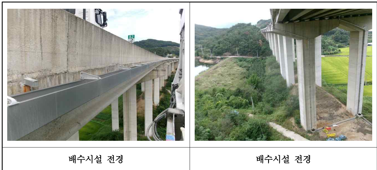
【사진 2.3.49】 배수시설 전경
