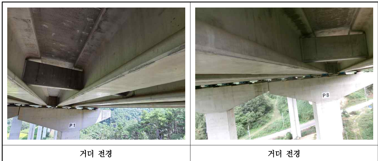
【사진 2.3.31】 거더 전경
