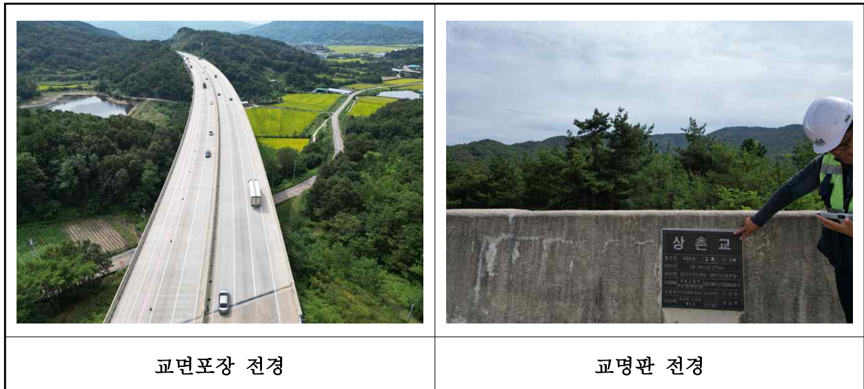
【사진 2.3.20】 교면포장 전경
