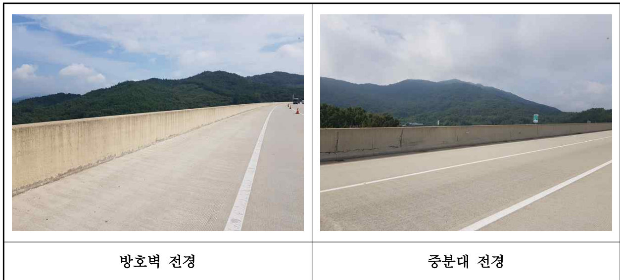
【사진 2.3.24】 방호벽 및 중앙분리대 전경
