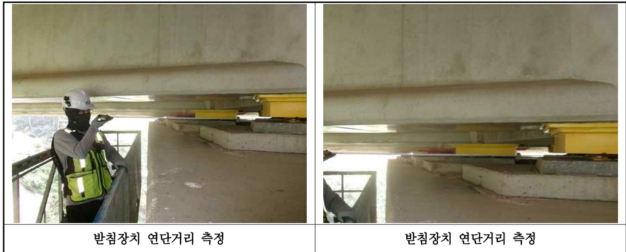
【사진 2.3.15】 교량받침장치 연단거리측정
