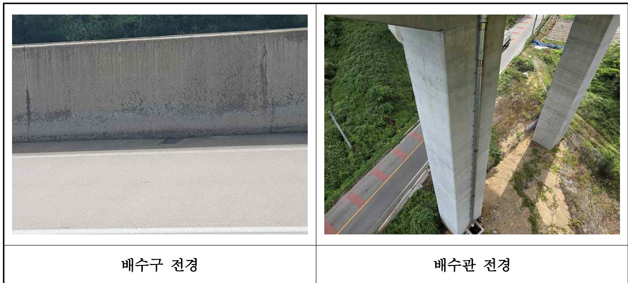
【사진 2.3.22】 배수시설 전경
