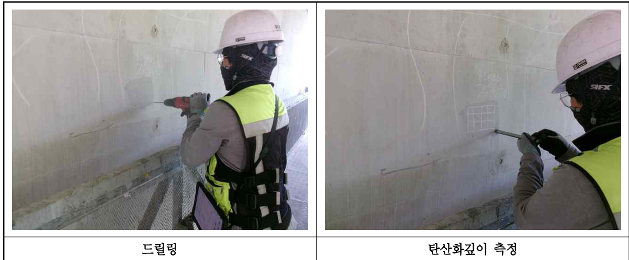
【사진 2.4.3】 탄산화 깊이 측정 현장사진
