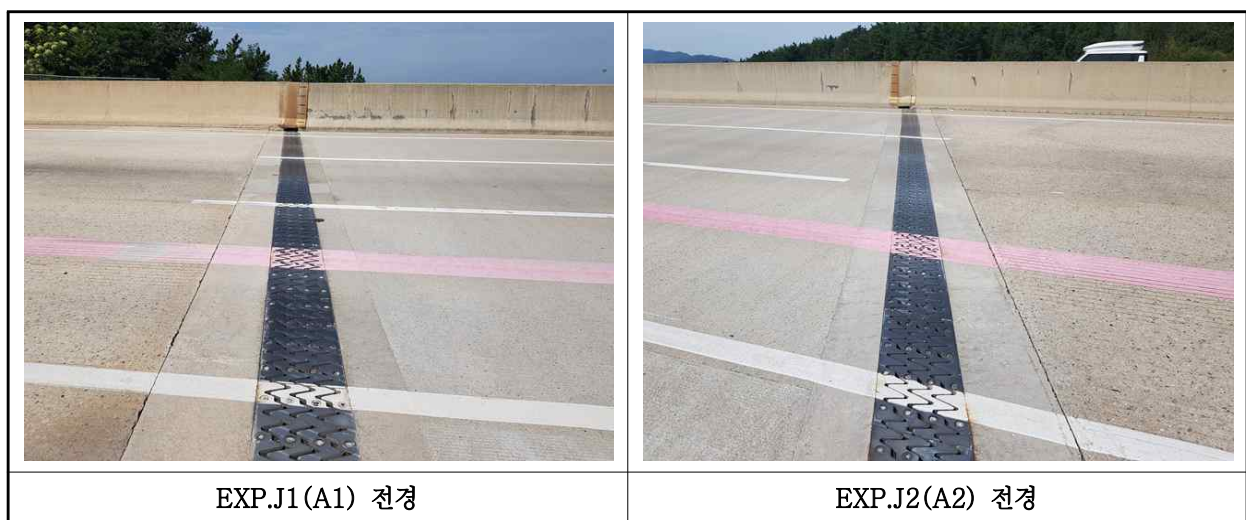
【사진 2.3.44】 신축이음장치 전경
