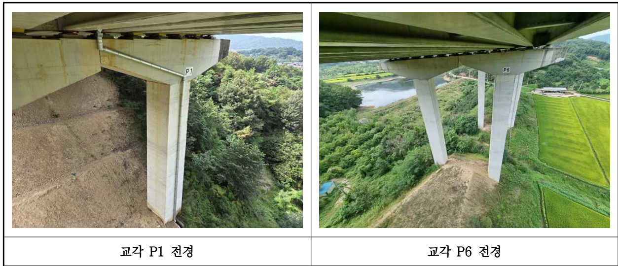
【사진 2.3.10】 교각 전경
