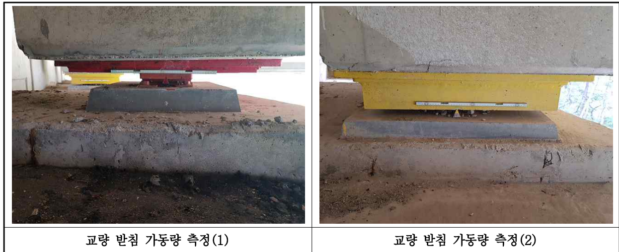
【사진 2.3.43】 교량받침 이동량 측정
