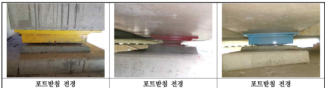
【사진 2.3.13】 교량반침 전경
