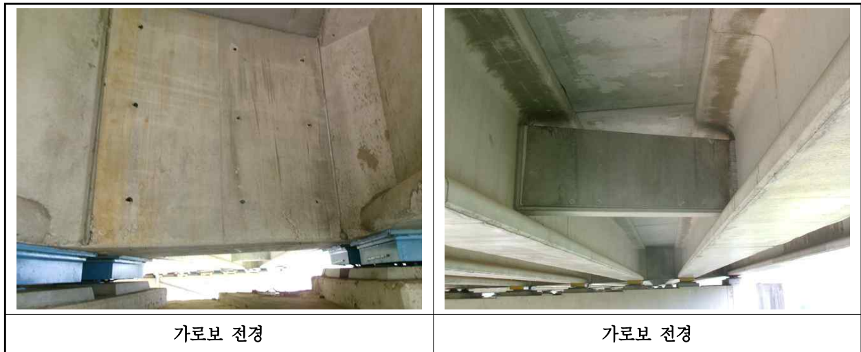
【사진 2.3.6】 가로보 전경
