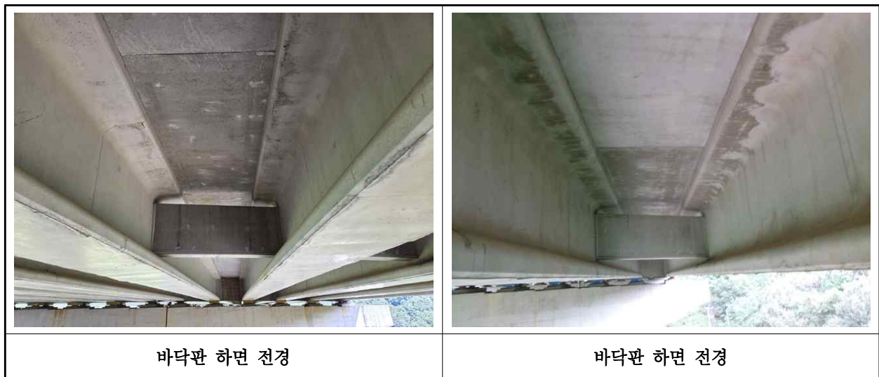
【사진 2.3.29】 바닥판하면 전경
