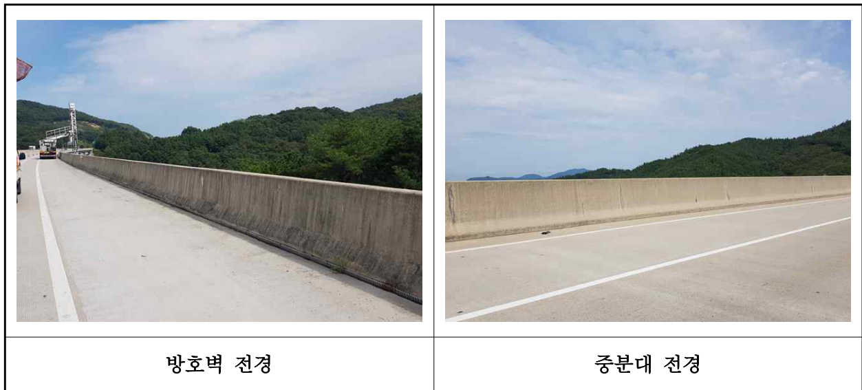
【사진 2.3.51】 방호벽 및 중앙분리대 전경
