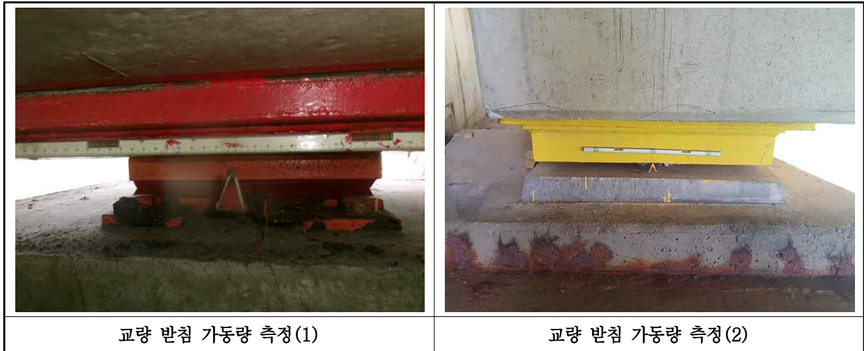
【사진 2.3.16】 교량반침 이동량 측정
