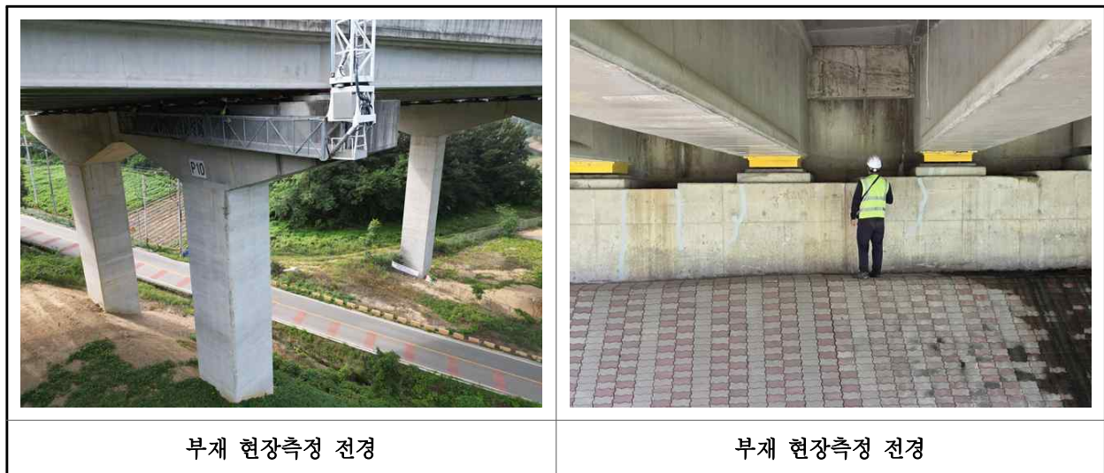
【사진 5.2.1】 부재 현장측정 전경
