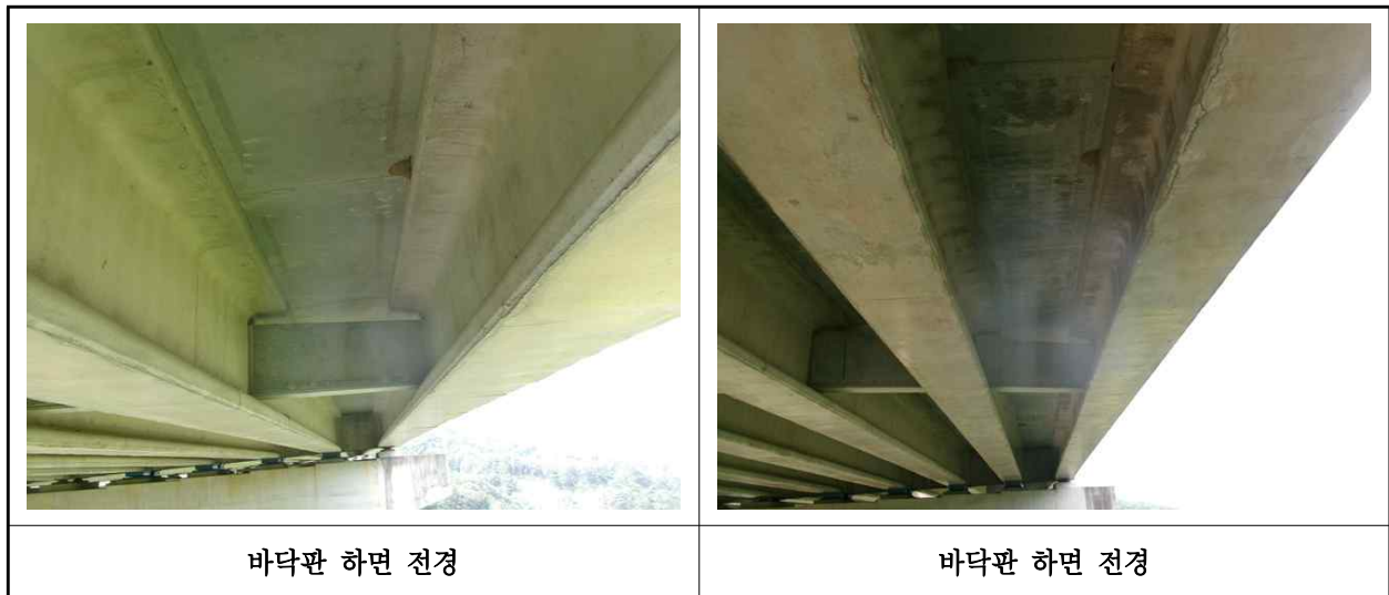
【사진 2.3.2】 바닥판하면 전경
