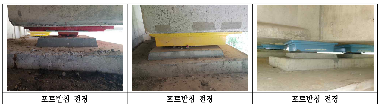
【사진 2.3.40】 교량반침 전경
