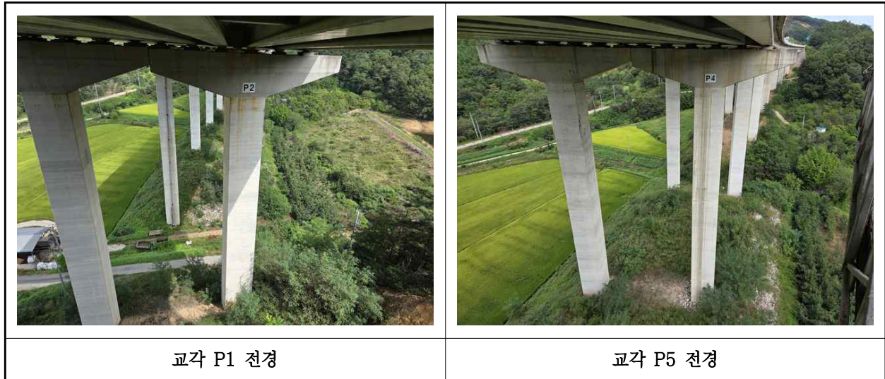
【사진 2.3.37】 교각 전경
