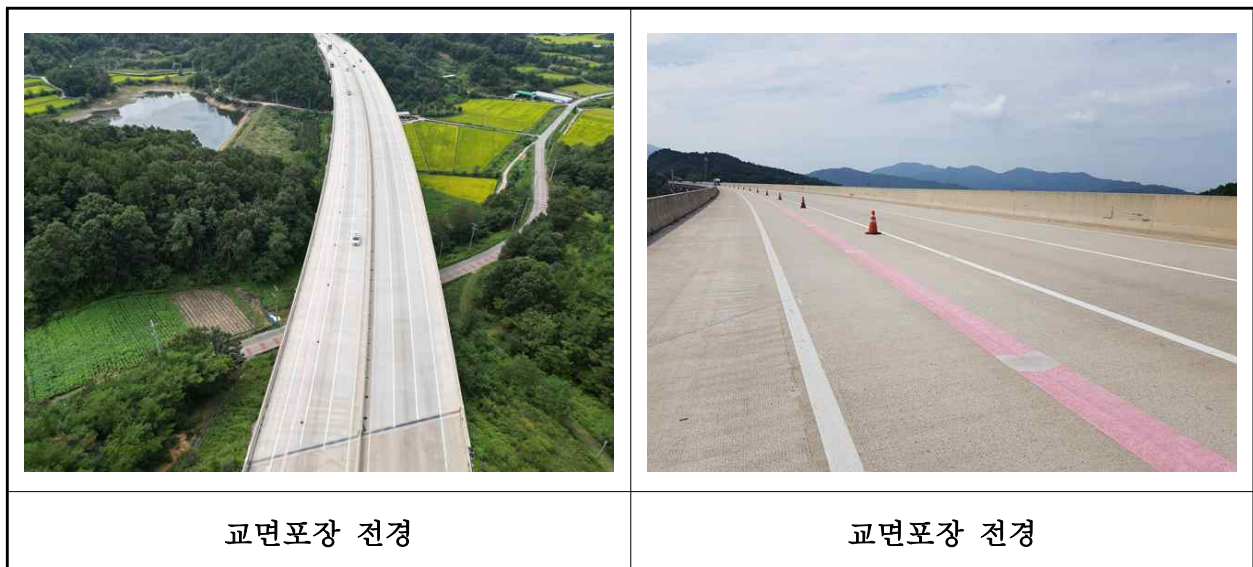
【사진 2.3.47】 교면포장 전경
