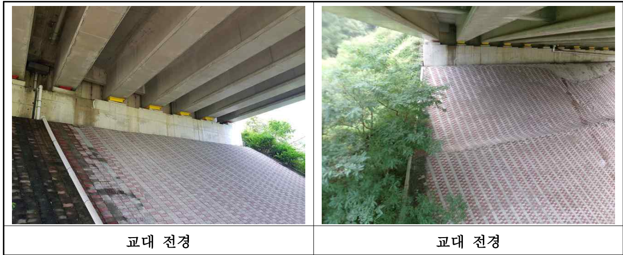
【사진 2.3.8】 교대 전경
