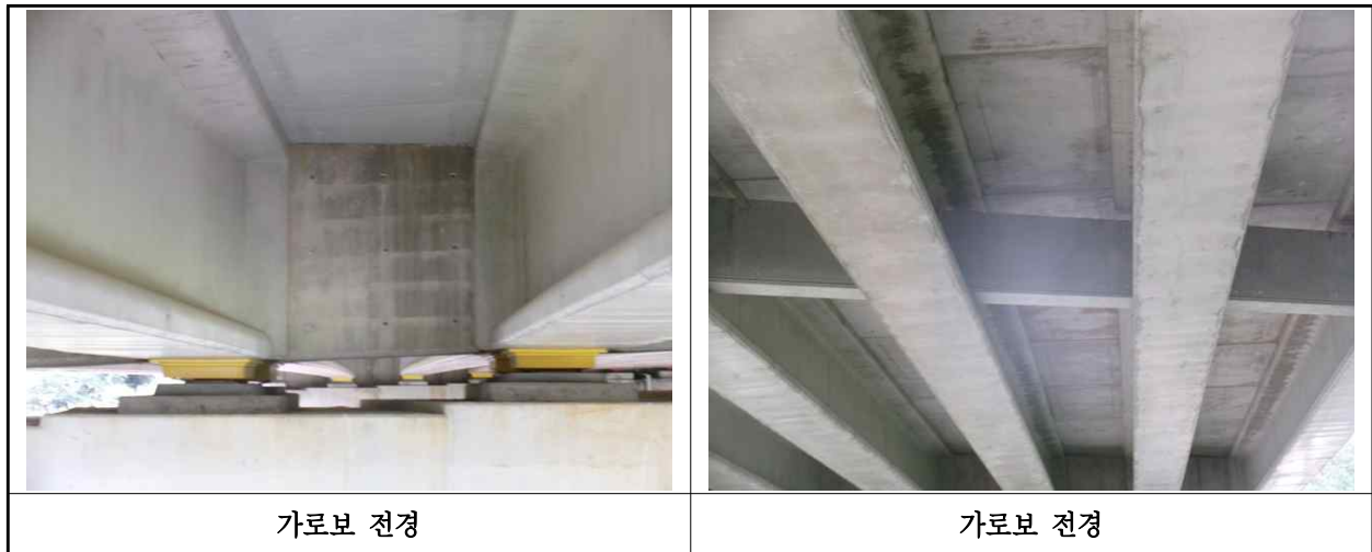
【사진 2.3.33】 가로보 전경
